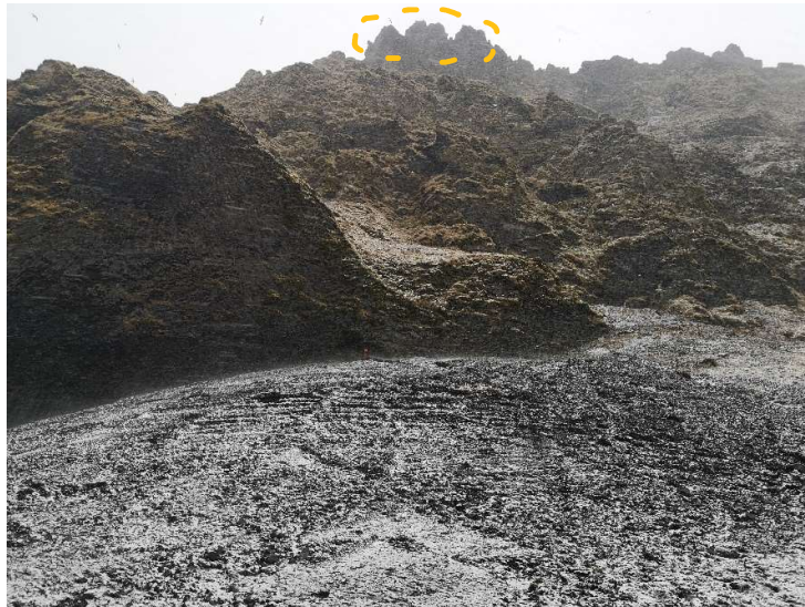
Mynd 7.3: Gangamunni fyrir veglínur 1b, 2 og 3 eru teiknaðar inn í svokallað Blánef, sem er kletturinn til vinstri á myndinni. Efst við brún er sumstaðar laust grjót (gult) en Blánefið og klettastallur ofan við er talinn verja gangamunna fyrir stóru hruni. Þó er mælt með því að hreinsa grjót úr klettabrúninni til að minnka hættu á slysum við hugsanlegar framkvæmdir. Mynd HBJ 2021.
